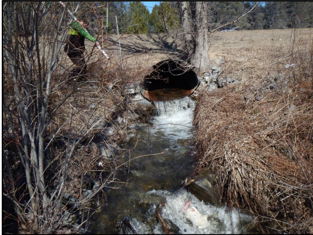
T-MH-AS-23 Culvert Outlet
