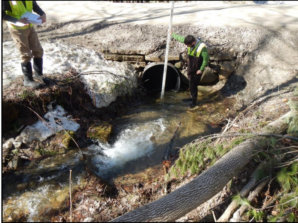
T-LU-S21 Culvert Inlet
