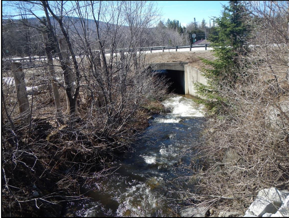
T-MH-S14 Culvert Inlet
