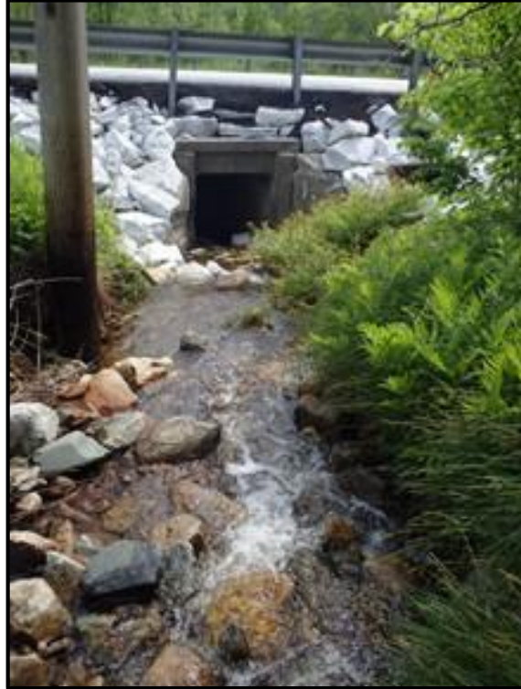
T-MH-S37 Culvert Inlet
