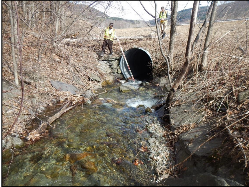
T-IR-S4 Culvert Inlet
