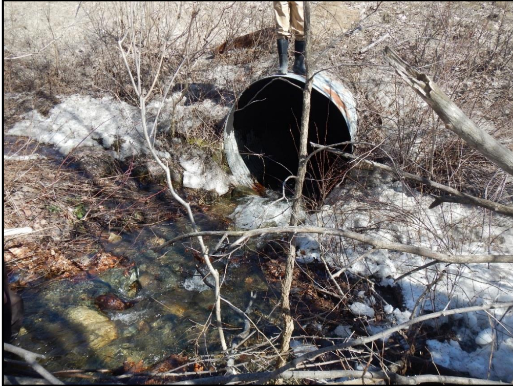
T-MH-S1 Culvert Inlet
