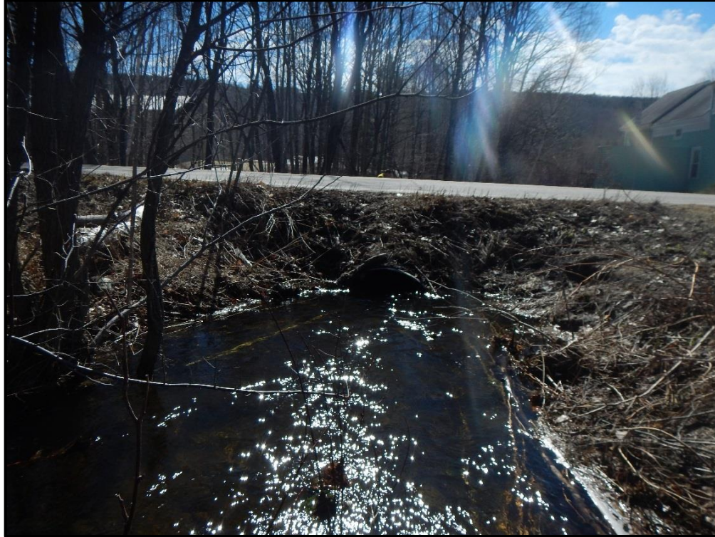
T-LU-S5 Culvert Inlet
