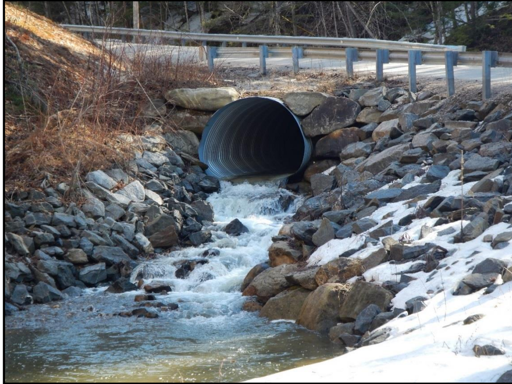
T-LU-S20 Culvert Outlet
