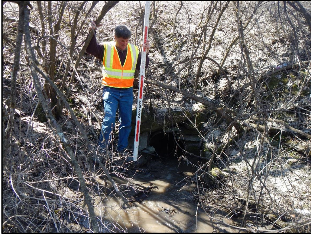
V-BE-AS-3 Culvert Inlet
