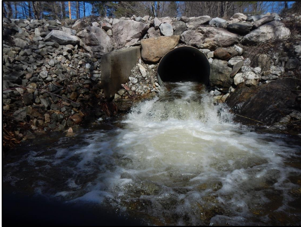
T-LU-S5 Culvert Outlet
