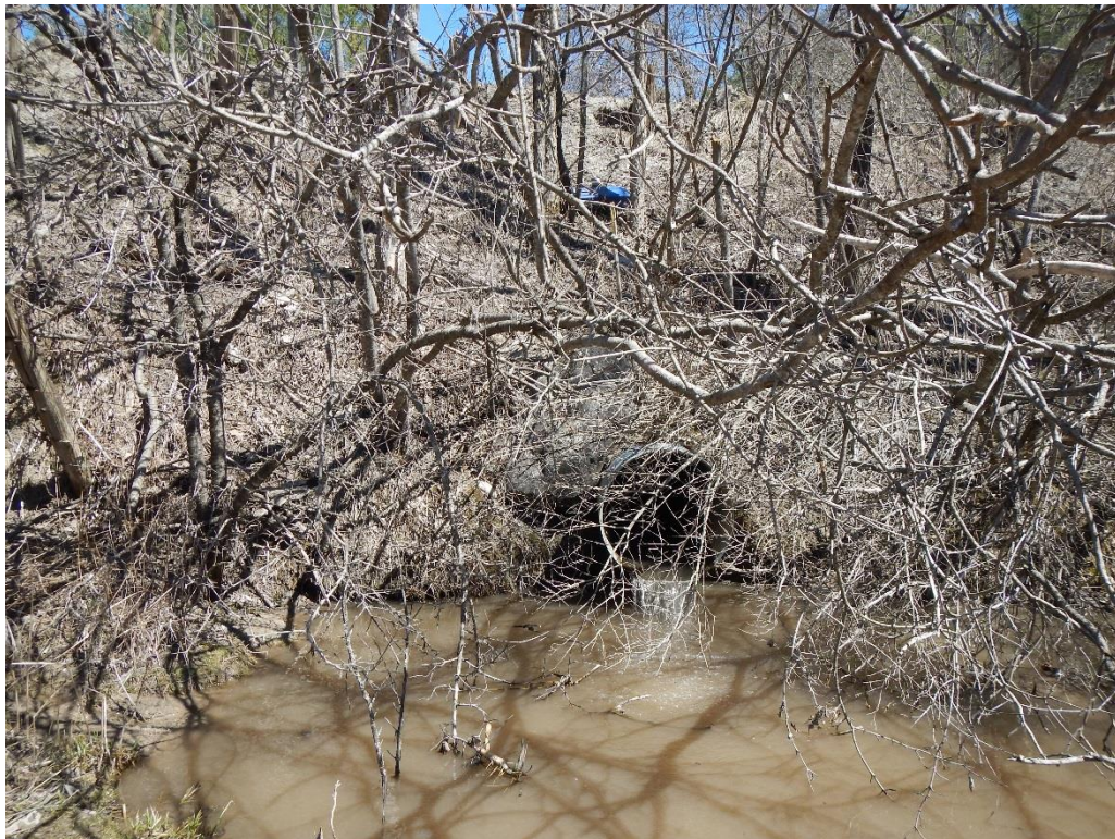
V-BE-AS-3 Culvert Outlet
