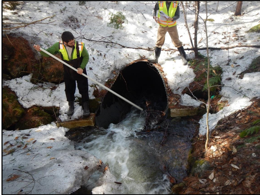
T-MH-AS-45 Culvert Inlet
