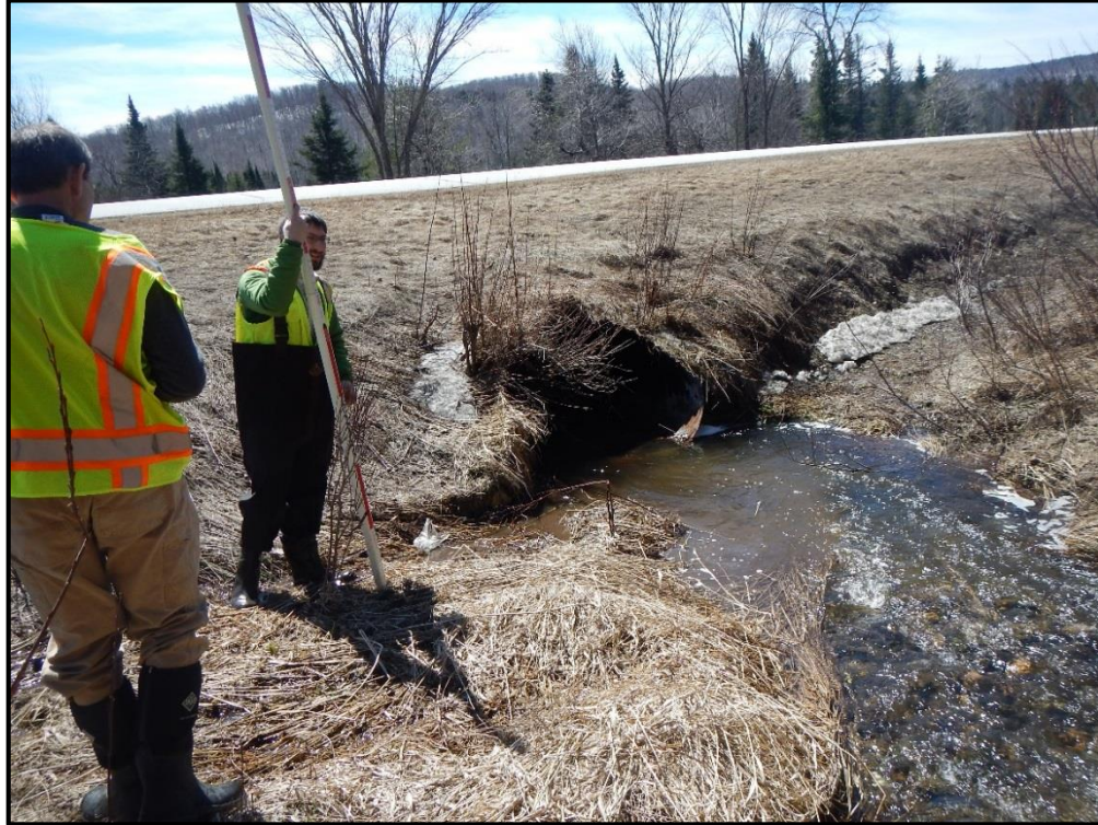
T-MH-AS-23 Culvert Inlet
