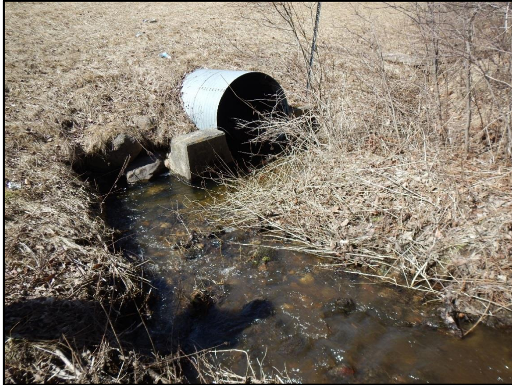
T-CL-S4 Culvert Inlet
