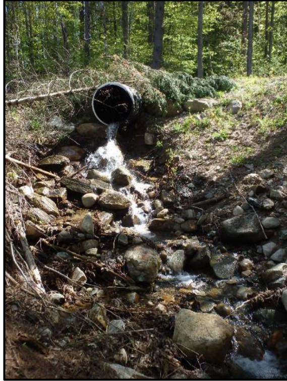
T-LU-S15 Culvert Outlet
