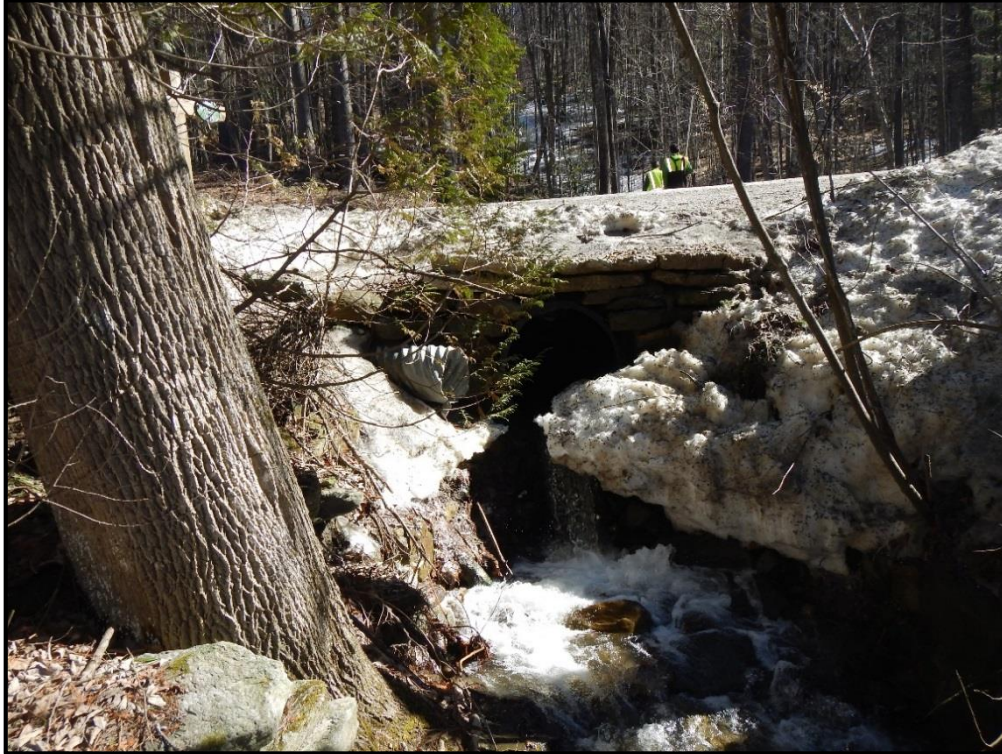
T-LU-S21 Culvert Outlet
