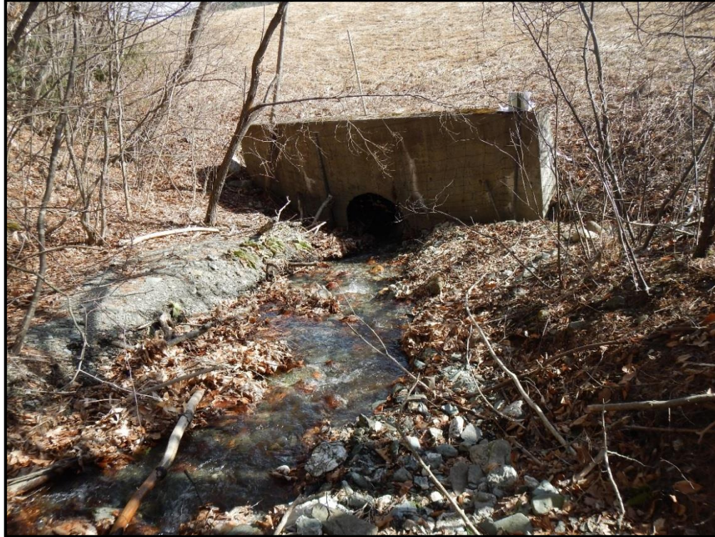
T-WR-S34 Culvert Inlet
