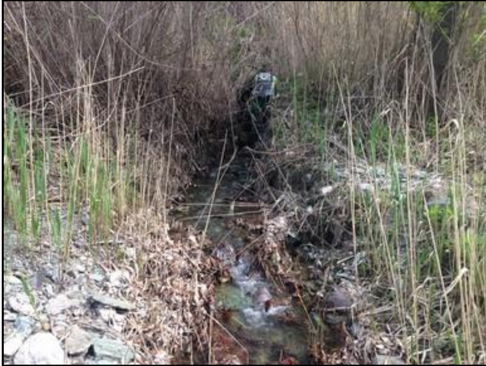
T-WR-S34 Culvert Outlet
