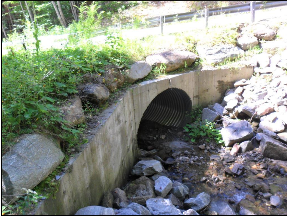
T-LU-S20 Culvert Inlet
