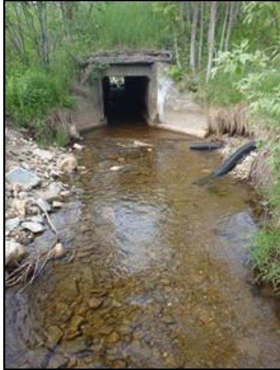
T-MH-S37 Culvert Outlet
