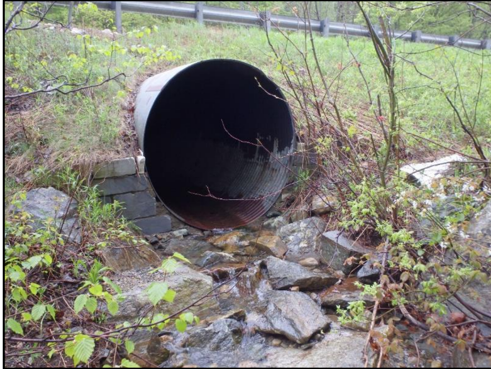
T-MH-S1 Culvert Outlet
